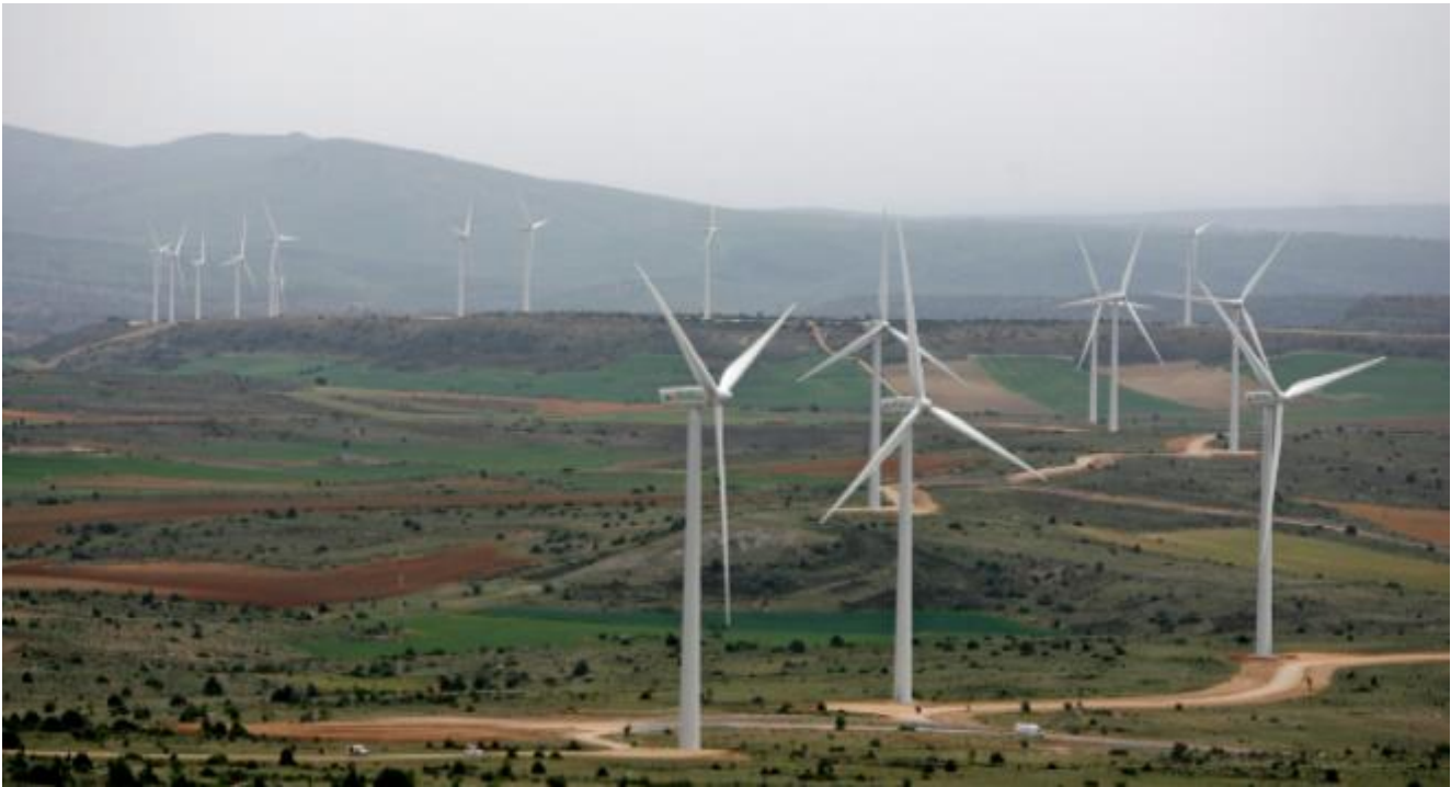
Parque eólico de Iberdrola. ALBERTO CUÉLLAR
