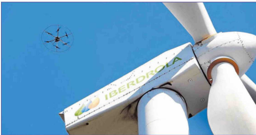
Aracnohélicoptero revisando palas de parque eólico de Iberdrola.
